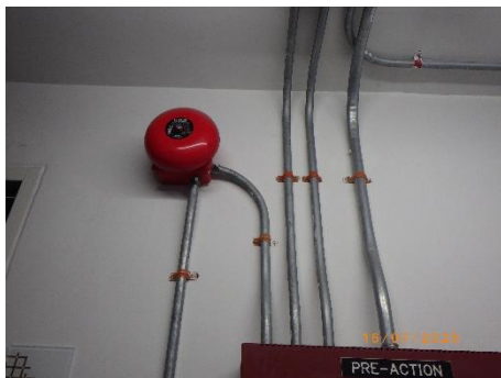
อุปกรณ์ส่งสัญญาณให้หนีไฟ แบบกริ่ง (Alarm Bell)
